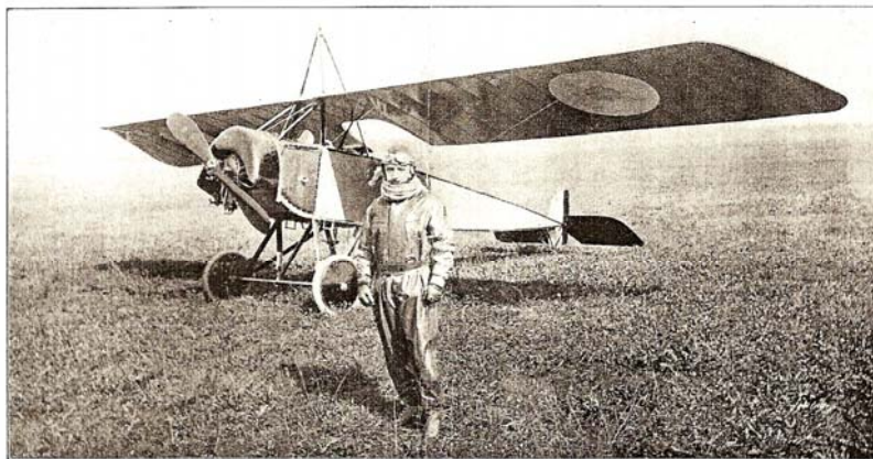
Notre compatriote à sa descente de l'appareil avec lequel il vient de monter à 6700 m. Le monoplane-parasol Morane a une forme d'ailes particulièrement intéressante. On remarque la particularité du train d'atterrissage donnant une grande élasticité à l'appareil. (Phot. « Suisse Sportive »)
